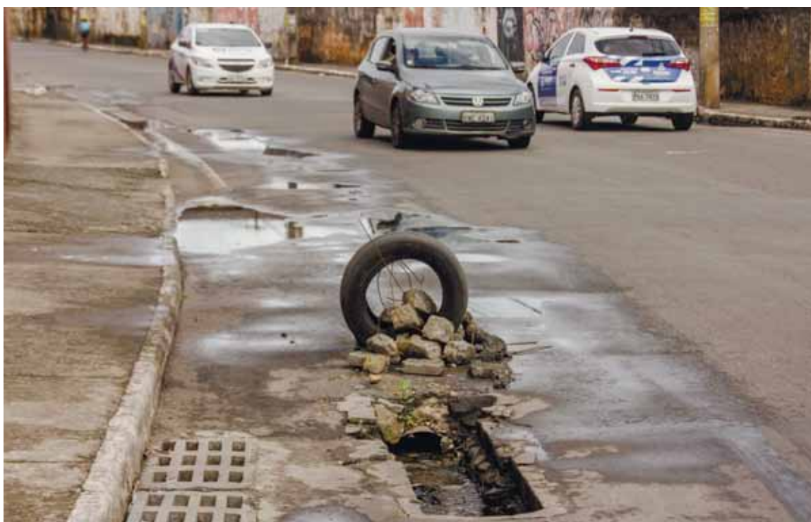
Trecho reformado recentemente já é alvo de reclamação por parte de motoristas e moradores; falta de infraestrutura pode causar acidentes
