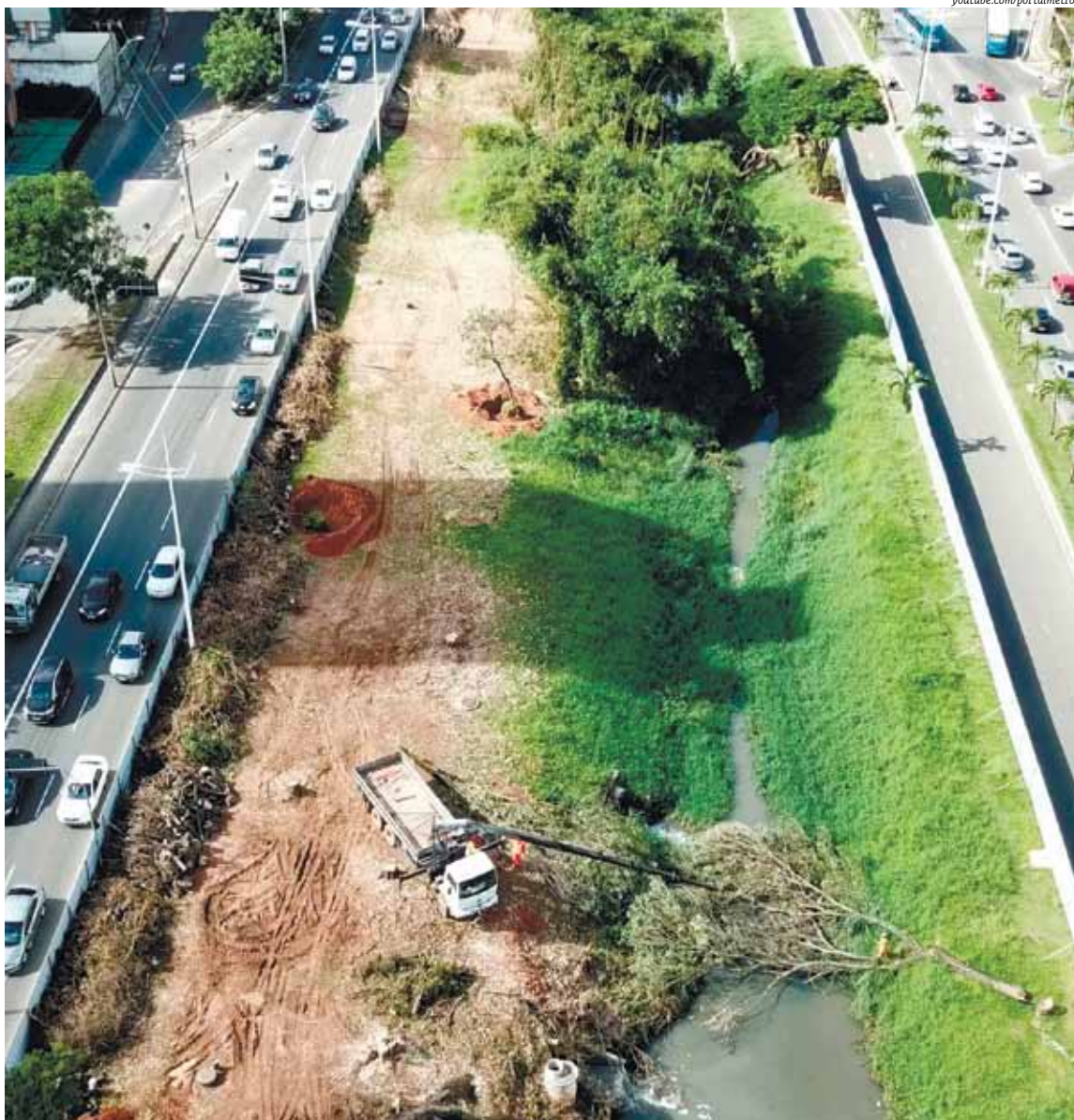
Trecho das Avenidas Juracy Magalhães e ACM já viraram canteiros de obras do BRT de Salvador; ambientalistas tentam conter avanço
