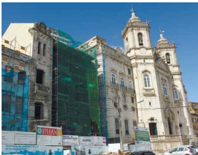
Restauração de edificações do conjunto da Rua da Conceição da Praia está em andamento
