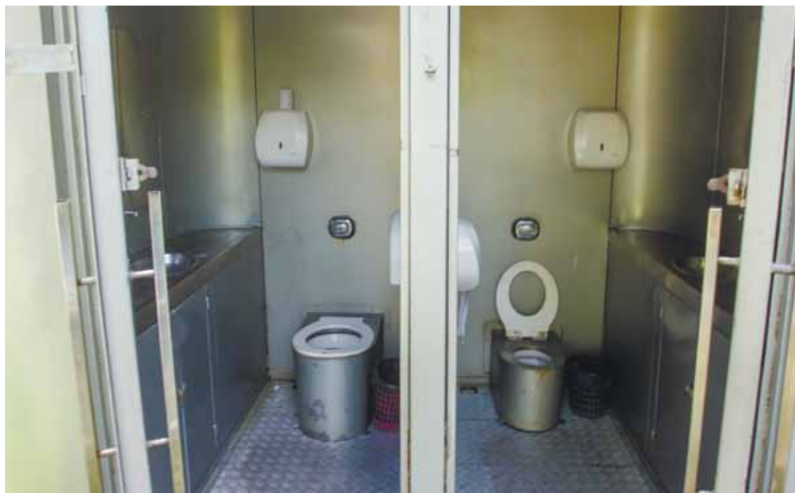
Únicos sanitários fixos instalados em Salvador, unidades do Campo Grande oferecem estrutura bem diferente dos banheiros químicos
