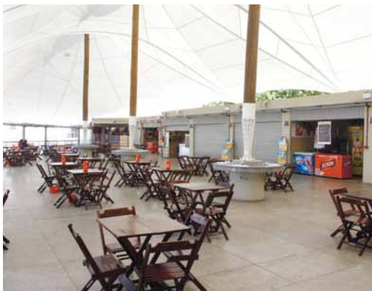
Cerca de dois anos e meio após abertura, mercado de Itapuã passa por reforma estrutural
