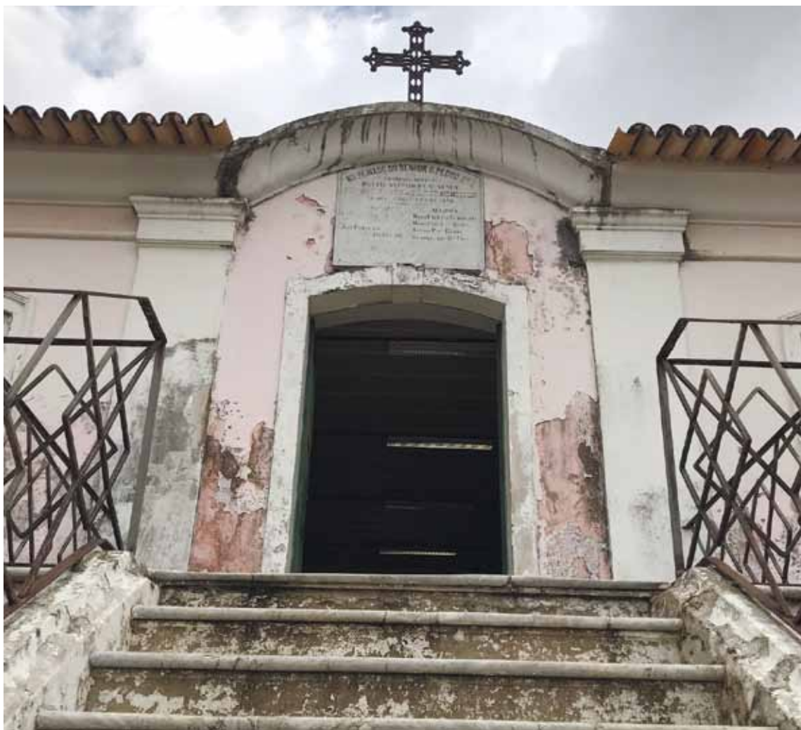
Paredes do Solar da Quinta do Tanque estão descascadas; pintura é um dos focos da reforma que deve acontecer no próximo ano
