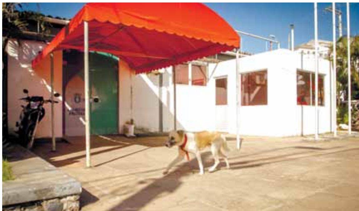
Prédio da prefeitura está sem identificação e, dentro, é possível ver muito entulho e lixo amontoado onde deveria funcionar o Poder público
