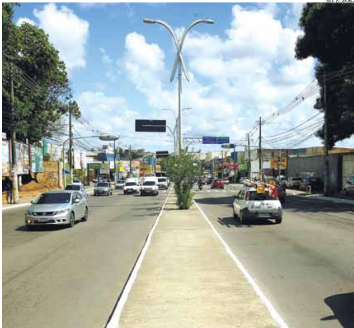
Vias do bairro engarrafam constantemente e deixam condutores na bronca; reforma pode mudar atual situação das avenidas
