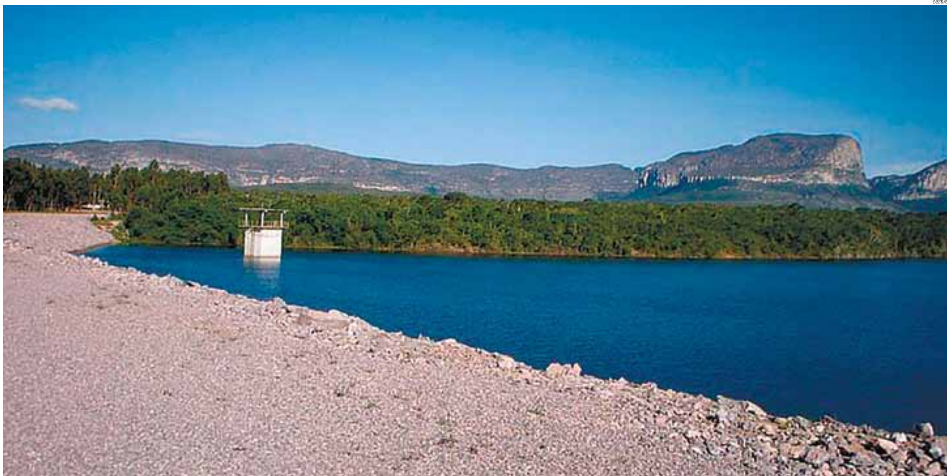
Barragens de água também causam preocupação; em Mucugê, na Bahia, a Barragem do Apertado está entre as dez apontadas pela Agência Nacional das Águas como em situação de risco. O relatório é do ano de 2018
