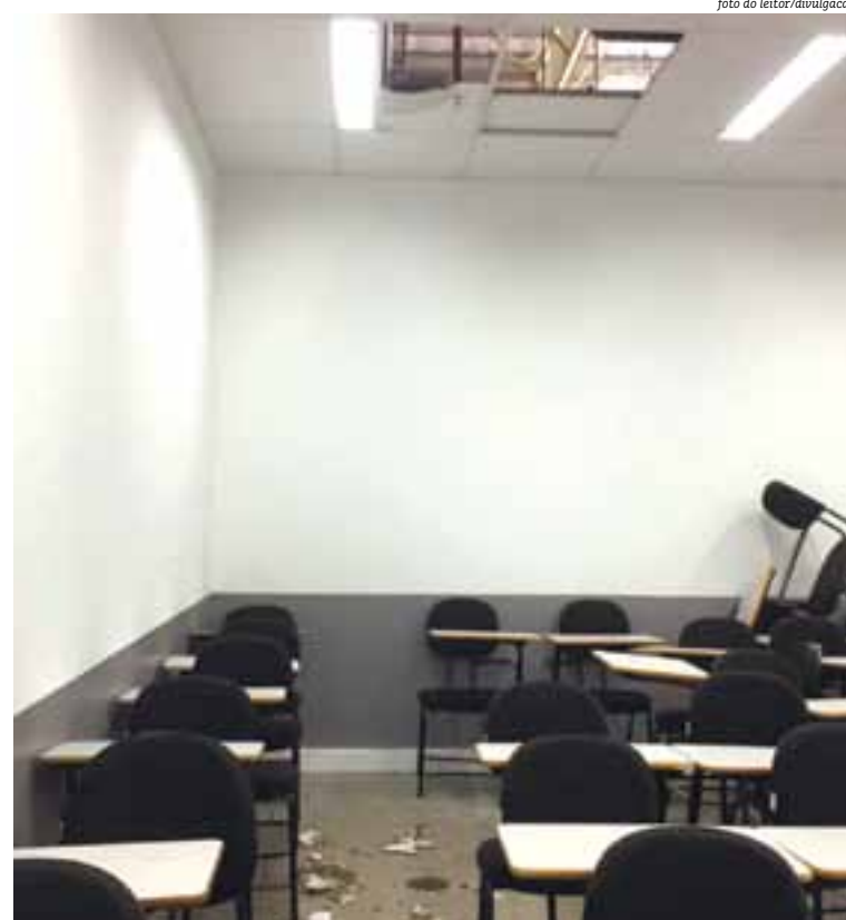
Em meio à reforma, forro de teto desaba dentro de sala em anexo no terceiro pavimento
