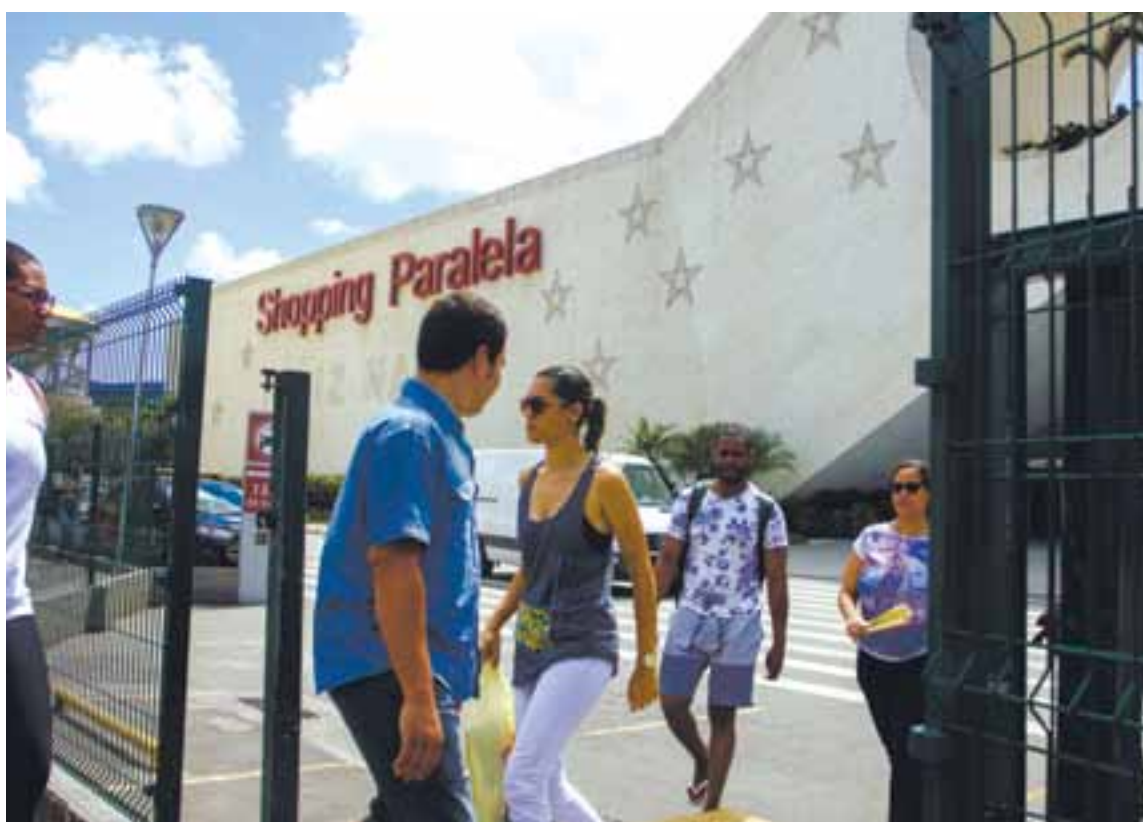
Consumidores ficam preocupados com situação do estacionamento do shopping, que apresenta novas rachaduras e ondulações
