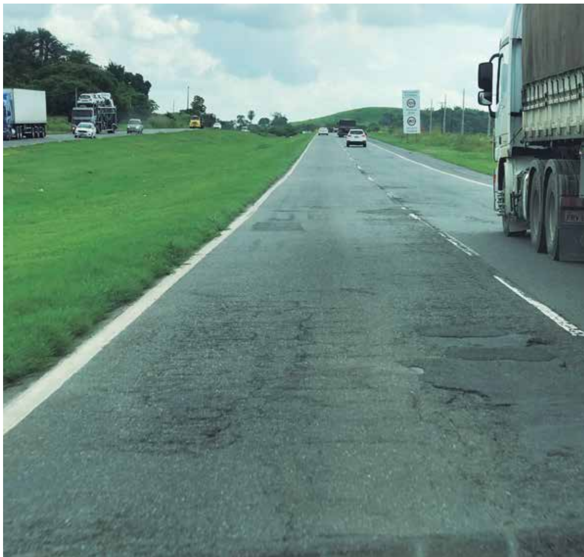
Estado de asfalto na BR-324 assusta quem precisa passar pela via; apesar do pedágio, manutenção não é feita pela concessionária
