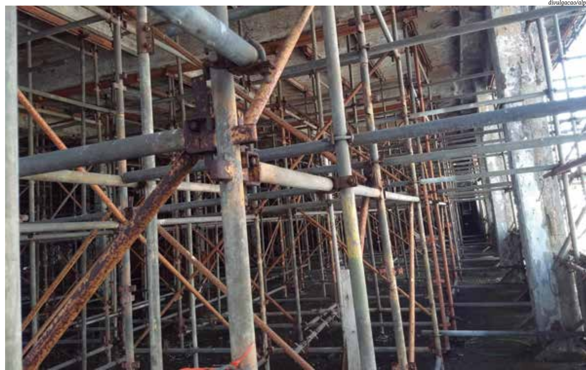
Esquecido pelas autoridades, prédio exibe marcas do descaso com estruturas da reforma, andaimes enferrujados e tapumes precários
