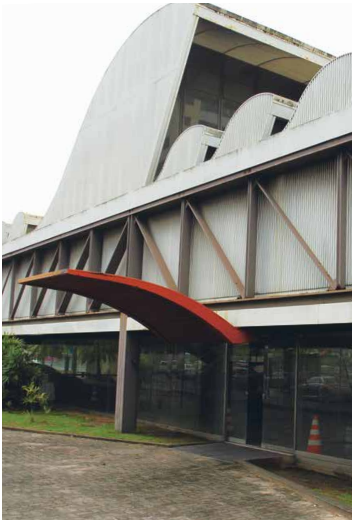
Local segue sem utilização e é guardado apenas por um segurança; vidros foram depredados e área de arborização foi tomada pelo mato
