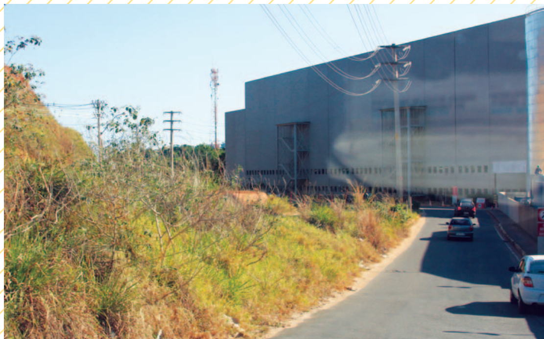
A entrada da Av. Tamburugy, pela Paralela, é por trás do Shopping que leva o apelido da avenida. O acesso foi inaugurado pela Prefeitura de Salvador em abril, como parte de um complexo viário, mas ainda não tem utilidade plena. E está repleto de mato ao redor
