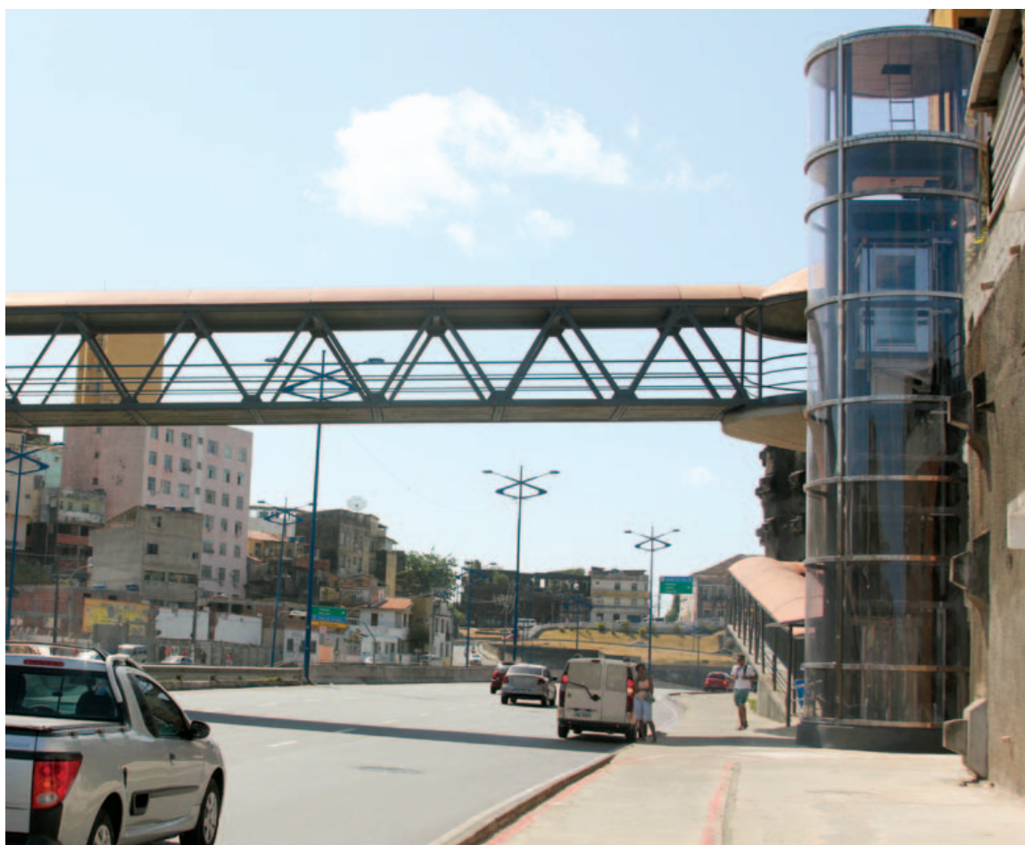
Na Av. Barros Reis, toda a instalação dos elevadores parece concluída, mas a famigerada “fase de testes” requer paciência da população
