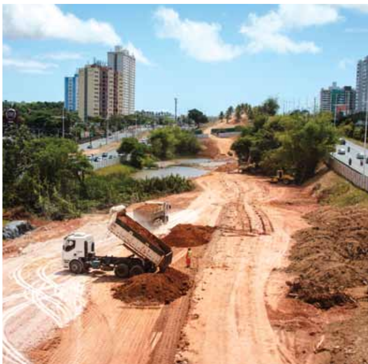
Da passarela do Centro Universitário Unijorge, é possível enxergar o estrago
