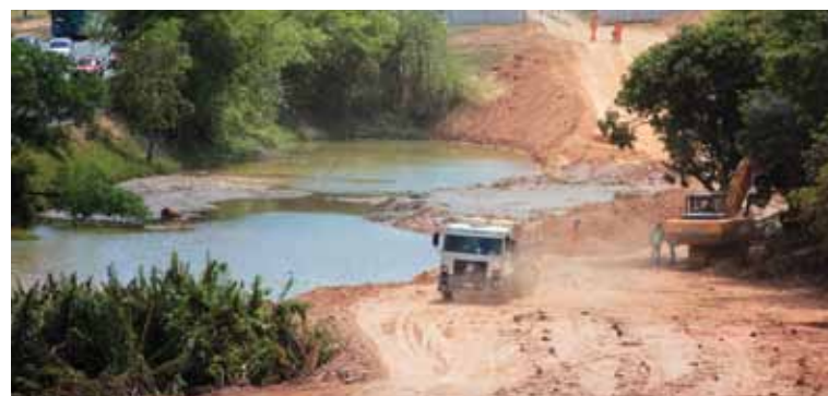
Antes abundantes no canteiro central e nas laterais da Paralela, lagoas estão desaparecendo
