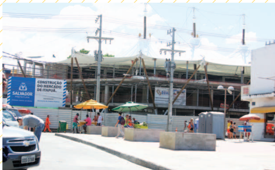
Em agosto, estivemos no Mercado de Itapuã e, finalmente, havia sinais de que a obra estava no fim — assim como a orla do bairro, que foi inaugurada dois meses e meio depois.
