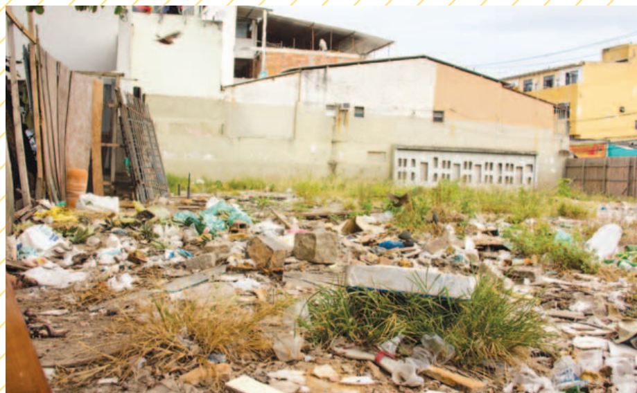
O Mercado de Itapuã foi demolido ainda em 2013, depois de a Defesa Civil (Codesal) detectar graves problemas nas estruturas, que não eram reformadas havia 25 anos. Até o início de 2014, porém, o cenário era só escombro.
