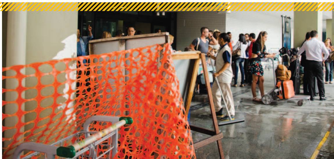
Em obras desde 2012, Aeroporto de Salvador era para ter sido entregue para a Copa do Mundo de 2014, mas ainda acumula problemas
