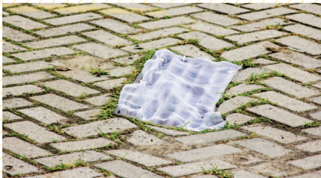
Na última semana, colocamos telas de proteção em todos os bueiros e bocas de lobo da nossa sede, a fim de evitar a criação de larvas do mosquito aedes aegypti . Além disso, plantas que acumulavam água no nosso jardim foram trocadas.
