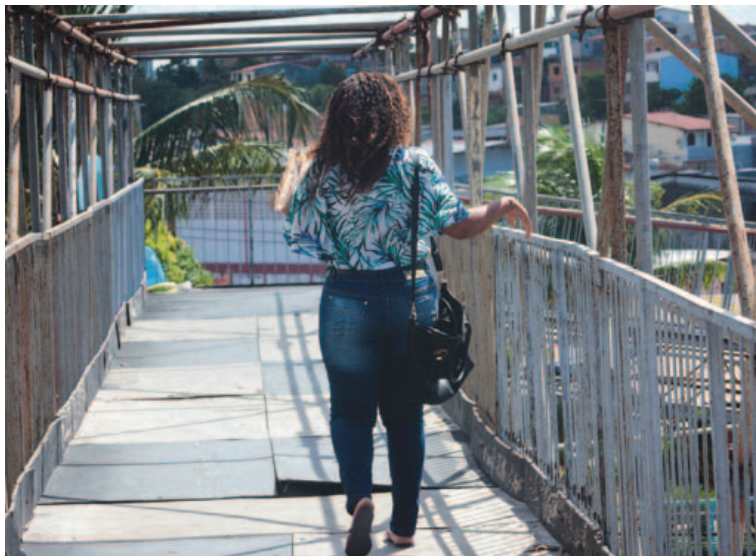
Nem precisa passar pela passarela pra saber que a estrutura não inspira qualquer confiança
