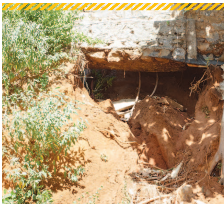
Rompimento da adutora causou instabilidade em um muro de um imóvel particular
