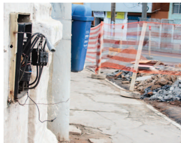
Na região da praia da Paciência, que deveria estar 100% em janeiro, ainda há até quadros expostos
