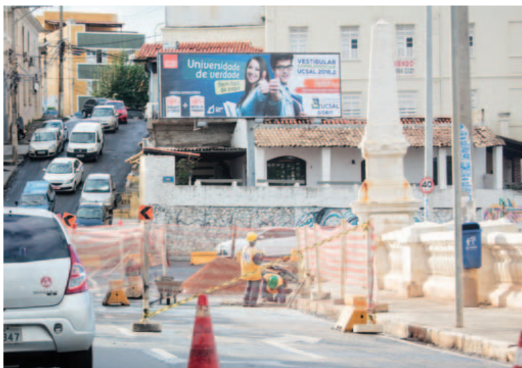
Quem passa pela Paciência há meses é obrigado a lidar com o congestionamento gerado pela obra
