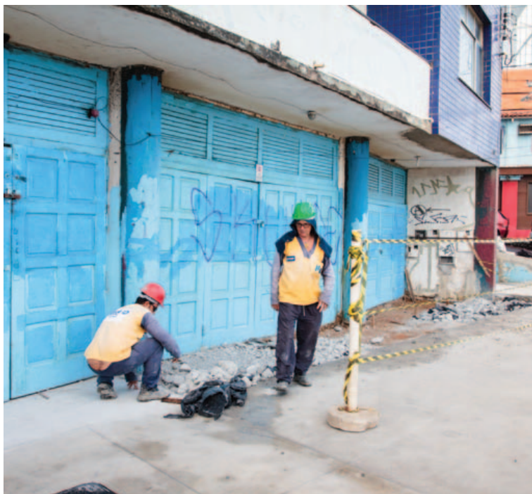
Calçada original causou infiltrações por meio do portão deste prédio na Paciência
