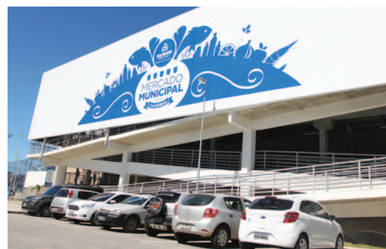
A beleza da fachada não reflete a situação em que vivem os comerciantes do mercado
