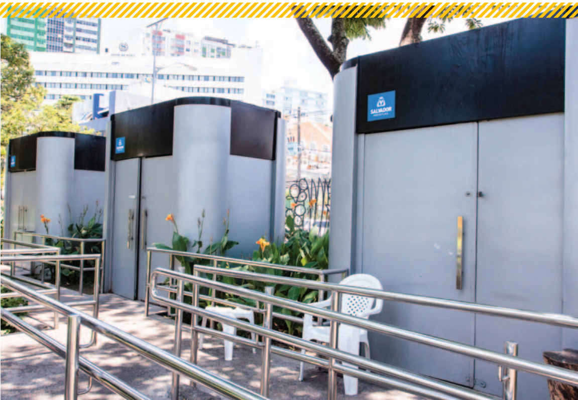
Banheiros fixos devem ter estes, colocados no Campo Grande, como modelo. Cabine antivandalismo é o trunfo da Semop para 2017
