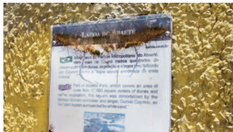
Até a placa que deveria receber os visitantes no Abaeté está corroída pela falta de cuidado
