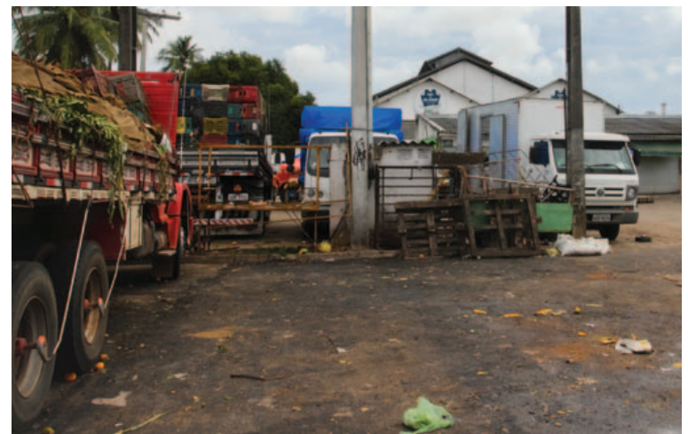
Há cinco anos em obras, a Feira de São Joaquim, em Salvador, tem apenas 20% da reforma concluída. Apesar de a gestão de Rui Costa ter adiantado o processo, ainda falta muito...
